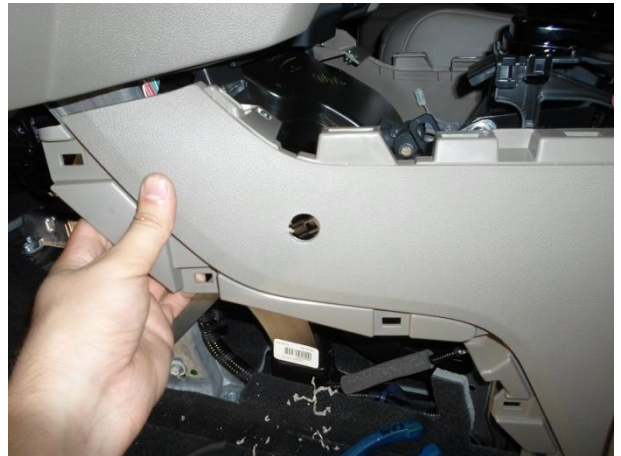
Разметить и выполнить отверстие в панели.
