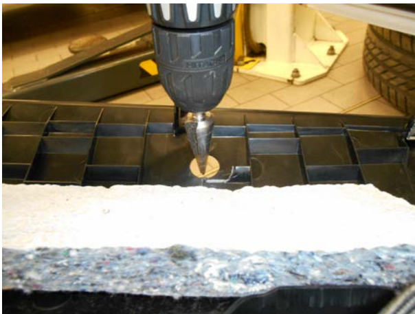
Разметить и выполнить отверстие в панели.
