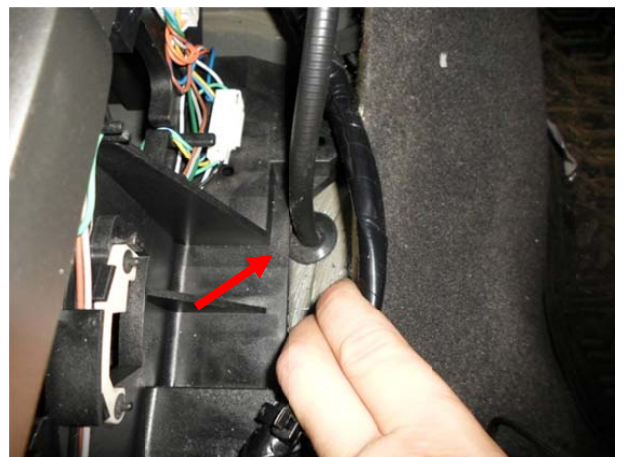
Выполнить отверстие в центральном тоннеле справа от селектора КПП, продеть оболочку, одеть уплотнительное кольцо.
