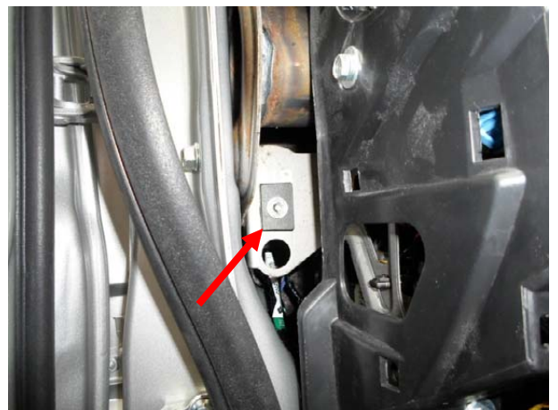
Притянуть кронштейн срывными болтами.
