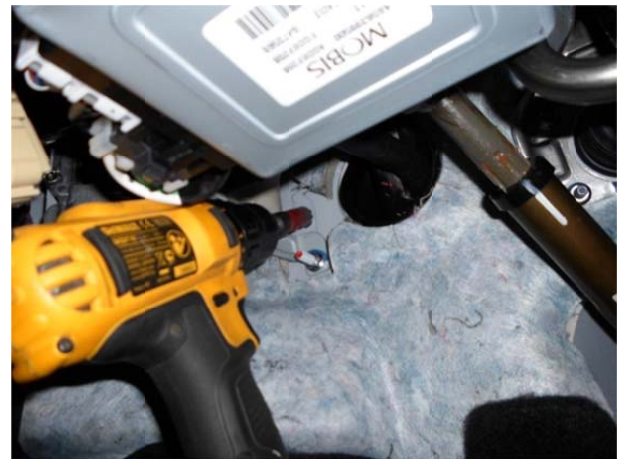
Выполнить отверстие в моторном щите, протянуть оболочку с замковым механизмом .
